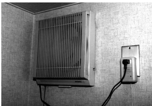
写真 7.2.4 換気扇とリモコンリレーコンセント
